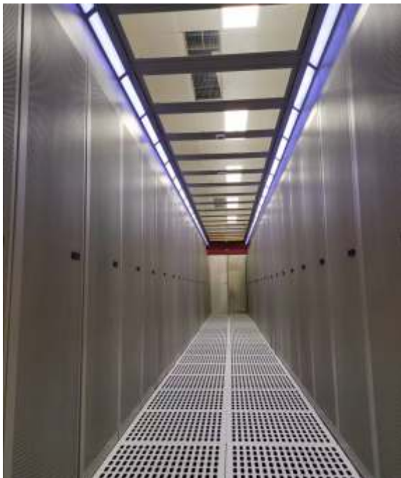
冷通道细节实景 CAC Details
