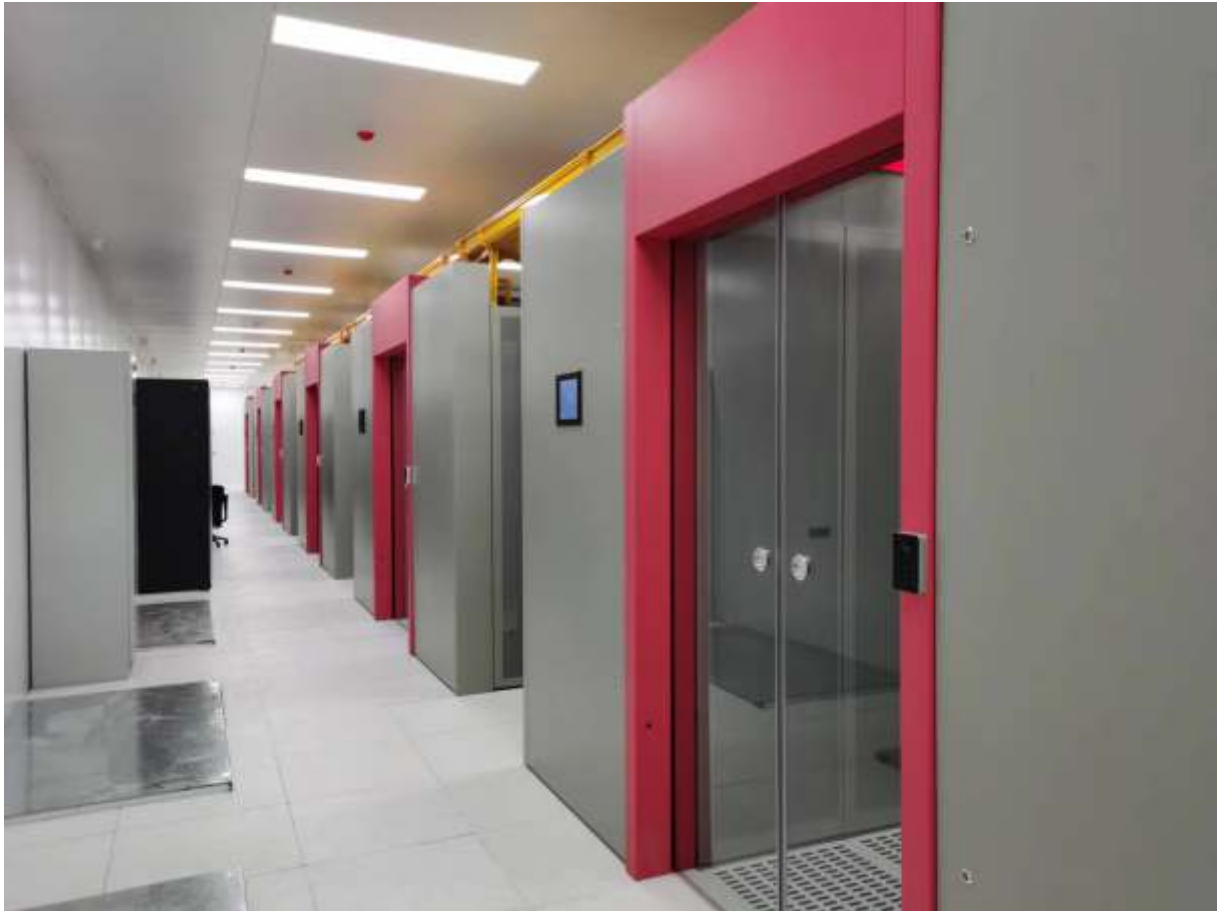
冷通道细节实景 CAC Details
