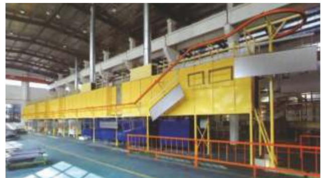
自动喷涂流水线 Automatic Spraying Line
