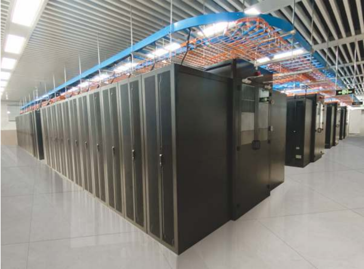
冷通道细节实景 CAC Details
