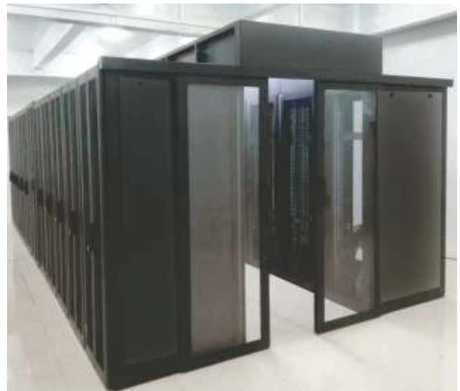
冷通道细节实景 CAC Details
