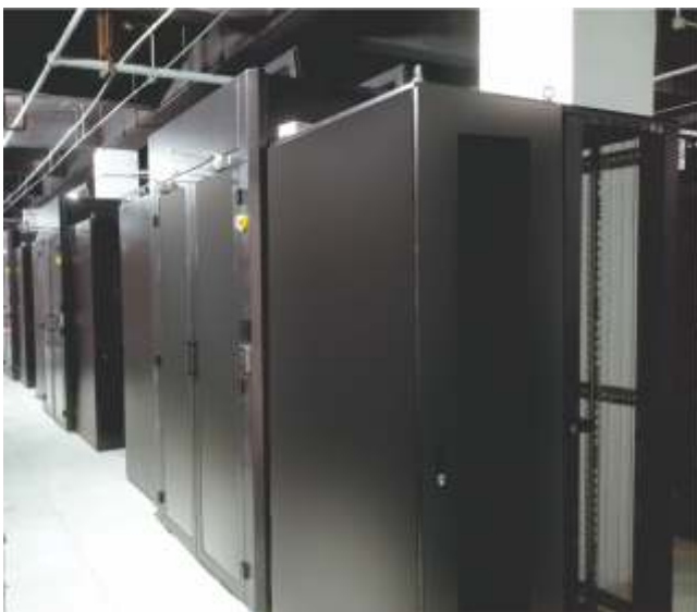
冷通道细节实景 CAC Details
